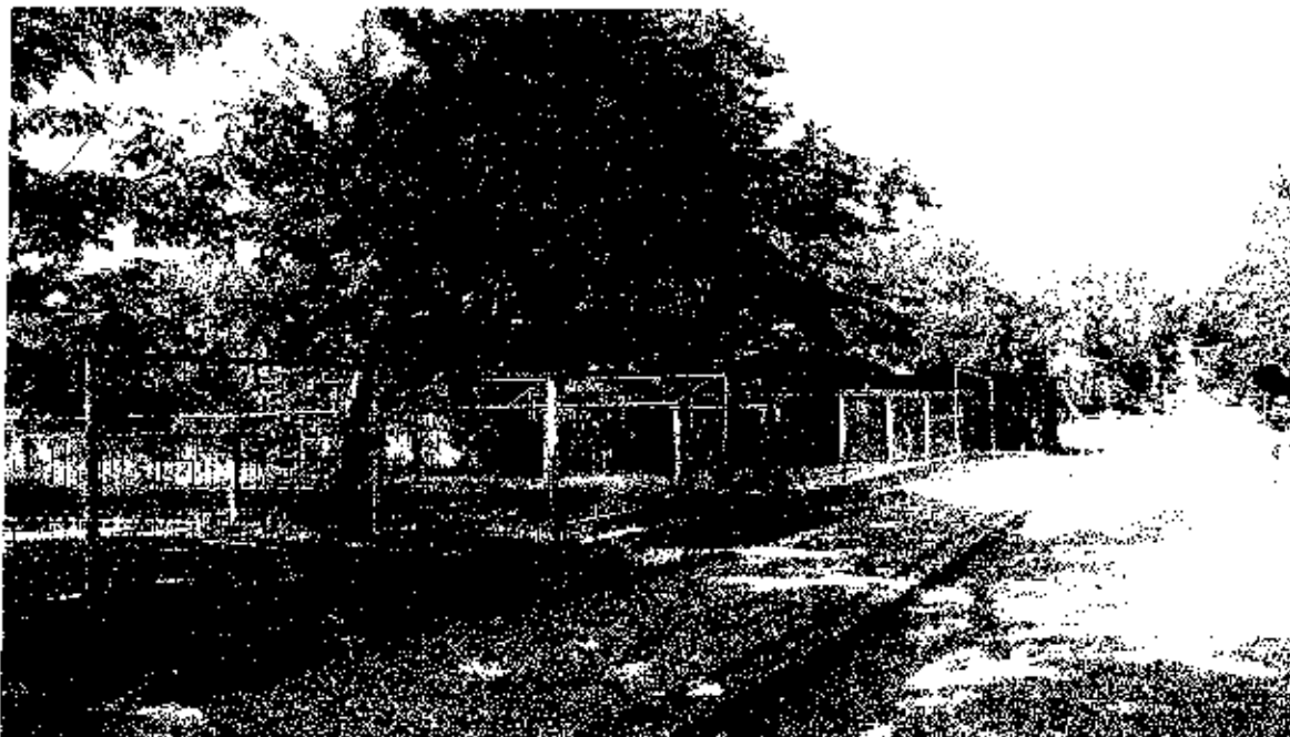
Gard laterală NORD – spre Aleea Castanilor
